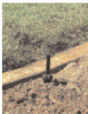
X-Flow-val az átfolyó vízmennyiség 98%-át visszatartja, ha a fúvókát eltávolítják, vagy megsérül.
